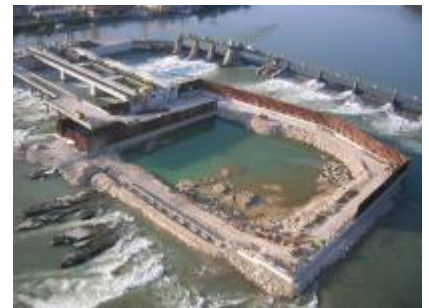
Baustelle des neuen Wehrs Rheinfelden Chantier du nouveau barrage mobile de Rheinfelden
