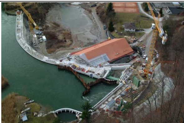
Links: Baustelle Magere Au A gauche: Chantier du barrage de la Maigrauge
