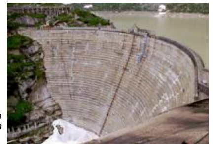
Staumauer Spitalamm Barrage de Spitalamm
