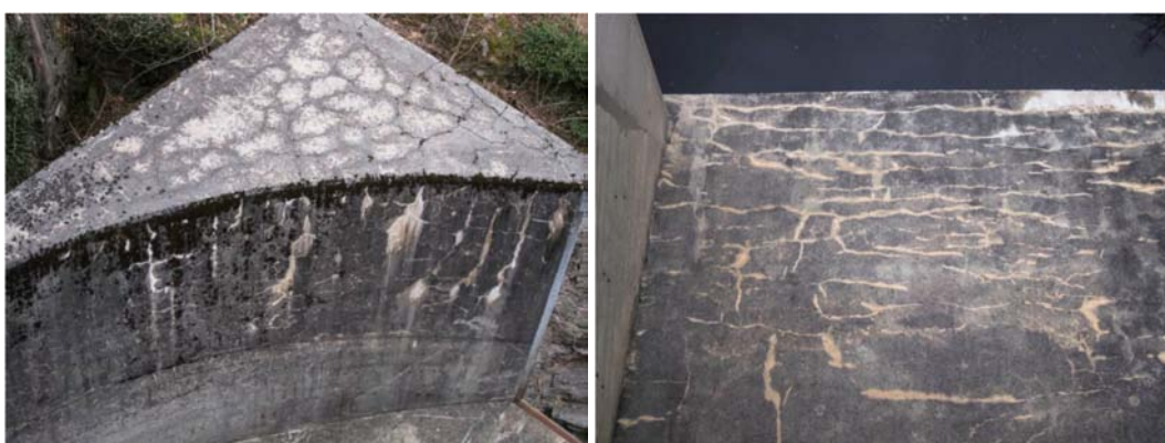
Figure 12: Fissures de RAG en forme de réseau à la sortie d'un évacuateur de crues (gauche) et fissures à l'entrée d'un évacuateur de crues avec directions préférentielles dues aux forces dans la structure (droite).
