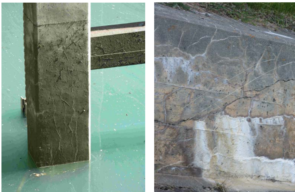
Figure 16: Pilier d'une passerelle de service avec des fissures de RAG dans la direction des sollicitations principales verticales (gauche) et mur de soutènement d'un évacuateur de crues avec fissures béantes (droite).
