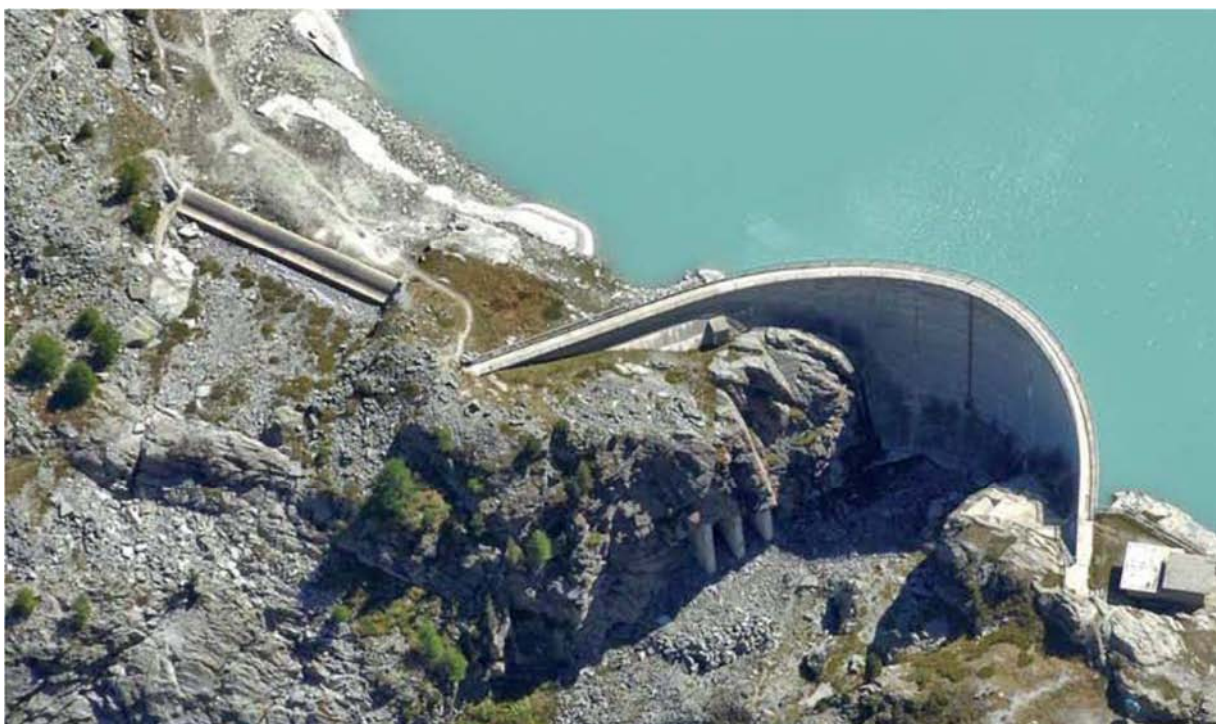
Figure 58: Vue aérienne du barrage de Tourtemagne et de l'évacuateur de crue en rive droite.
