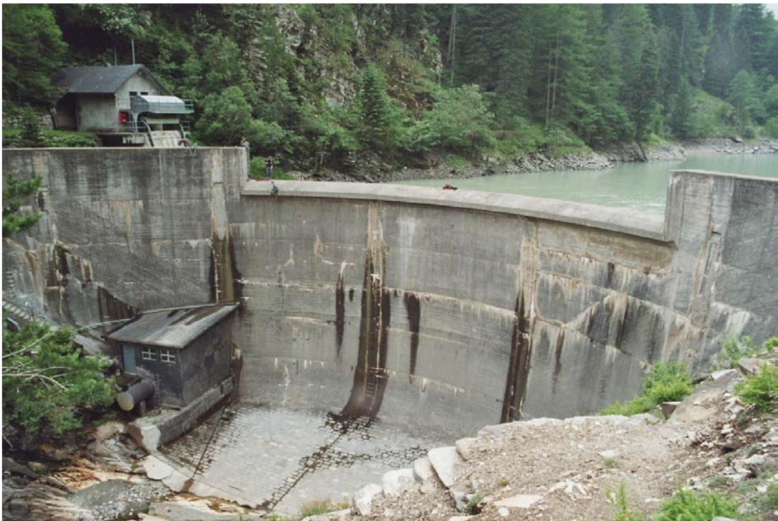
Figure 1: Ancien barrage de Sera endommagé par la RAG (vallée de Zwischbergen près de Gondo VS)
