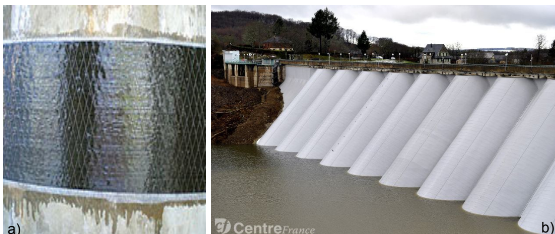
Figure 83: Exemples de mesures de mitigation: a) protection par fibres de carbone; b) protection avec membrane PE.
