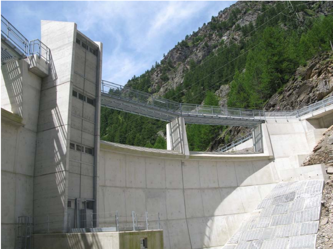
Figure 22: Barrage nouvellement construit au Zwischbergental près de Gondo (VS) avec un agrégat non réactif transporté par camion [17].
