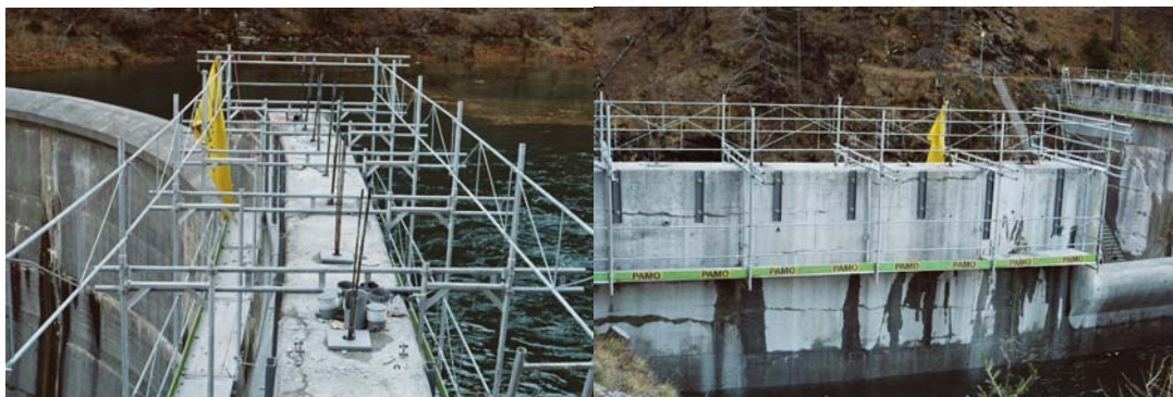
Figure 19: Mise en sécurité provisoire d'un couronnement de barrage endommagé par la RAG avec des ancrages précontraints verticaux et des sangles verticales en acier pour les cas de crues et de tremblements de terre.
