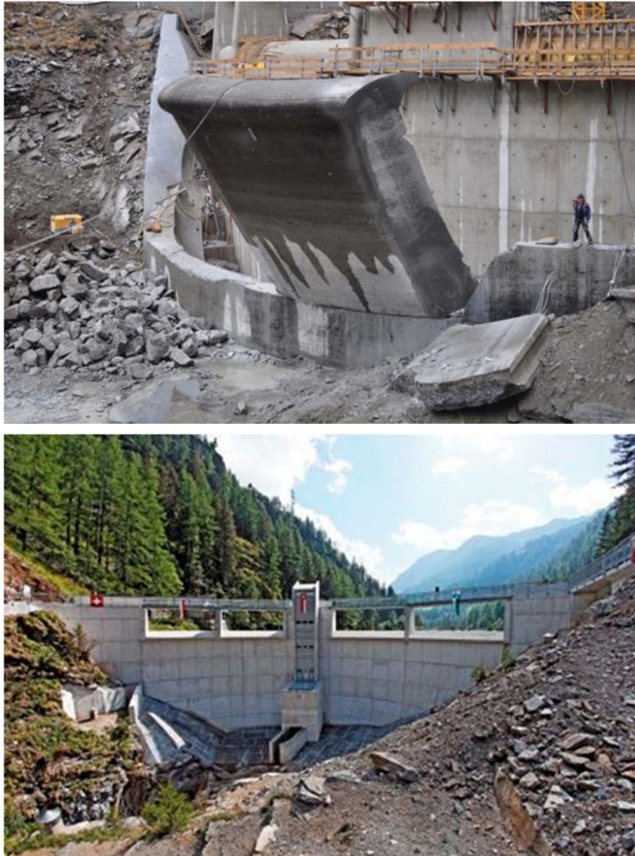
Figure 73: Démolition du 1 er barrage et vue aval du nouveau barrage de Sera.
