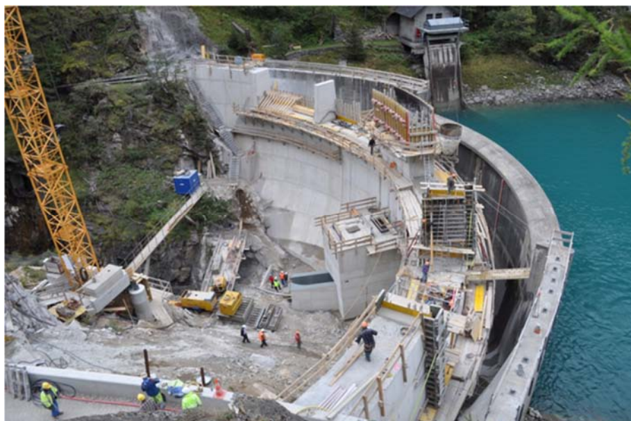
Figure 72: Travaux de construction du nouveau barrage de Sera, situé juste à l'aval de l'ancien.
