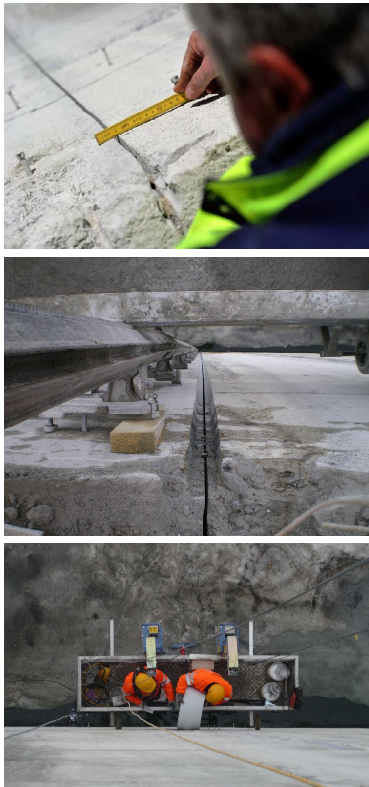
Figure 81: Préparation et pose de l'étanchéité amont.
