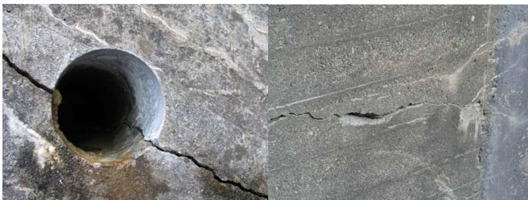
Figure 18: Détermination de la profondeur d'une fissure structurale sur le parement aval d'un barrage-voûte soumis à la RAG au moyen du prélèvement d'une carotte (gauche) et fissure avec décrochement sur le parement amont d'un barrage-voûte.
