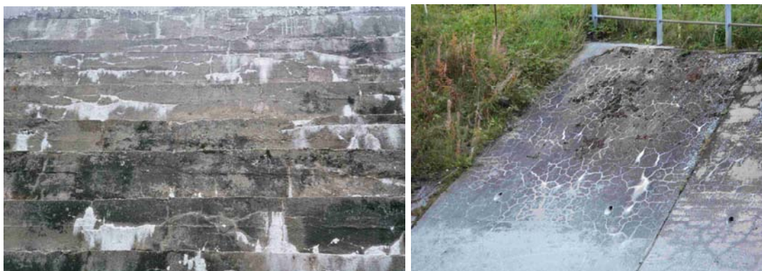
Figure 13: Fissures de RAG avec fortes efflorescences sur le parement aval en escaliers d'un barrage-poids (gauche) et protection de rive à l'aval d'un seuil avec formation en réseau de fissures de RAG (droite).
