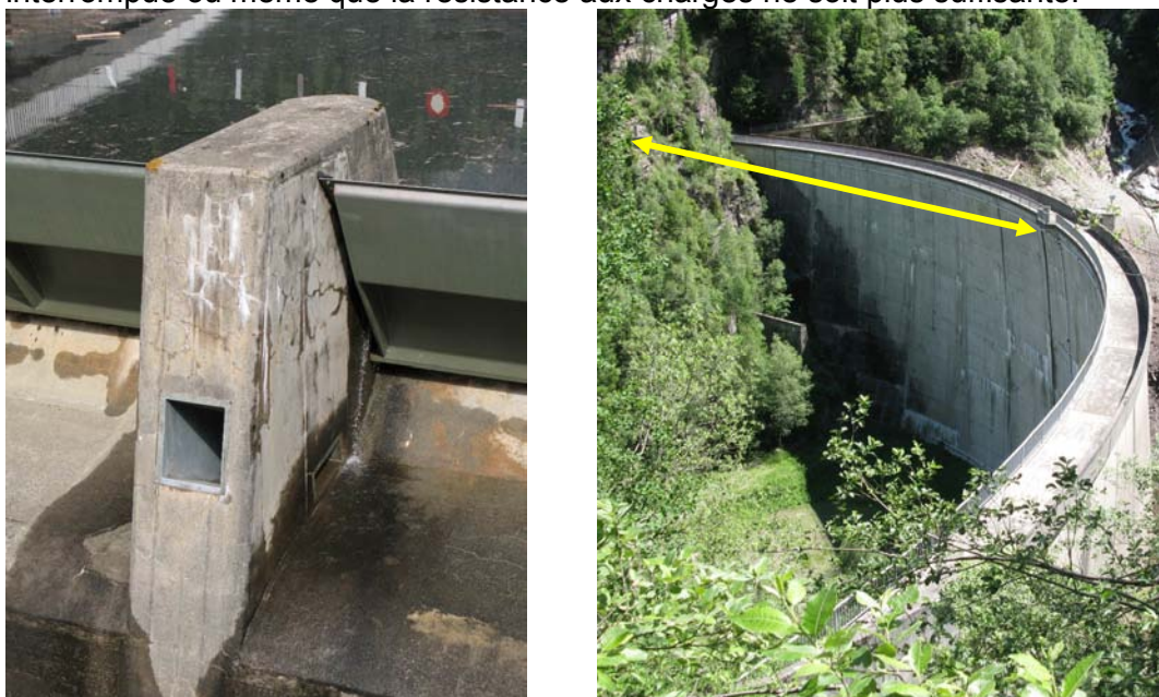
Figure 17: Les vannes ne peuvent plus être bougées suite à un gonflement dû la RAG (gauche) et des visées géodésiques sont interrompues suite au soulèvement d'un parapet dû à la RAG sur le couronnement (droite).
