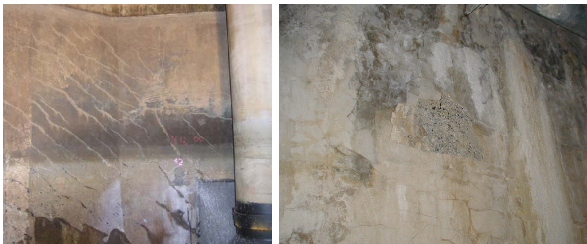
Figure 61: Etat de surface de certaines parois de parties immergées de la centrale.
