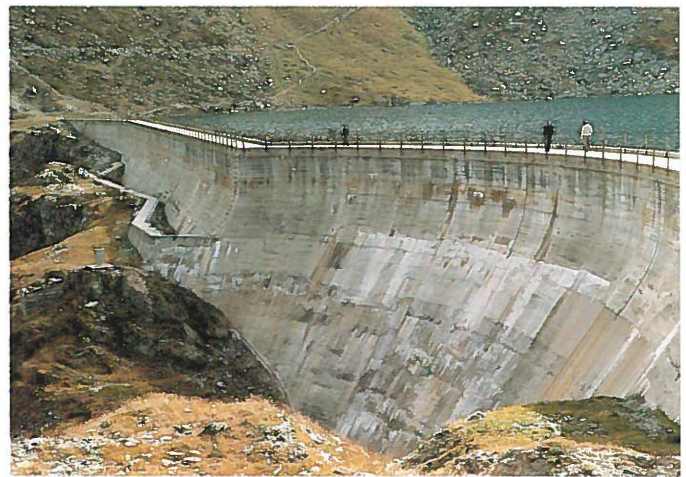
Figure 13. Barrage d'Ilsee/Ilsee dam.
