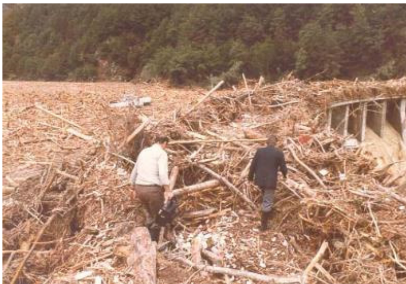
Figure 2: Obstruction de l'EDC du barrage due à la présence de bois flottant après les crues de 1978 (Source: Ofima)
