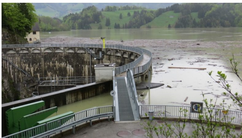
Figure 5: Volumes de bois flottant dans le réservoir de Montsalvens lors d'une crue
