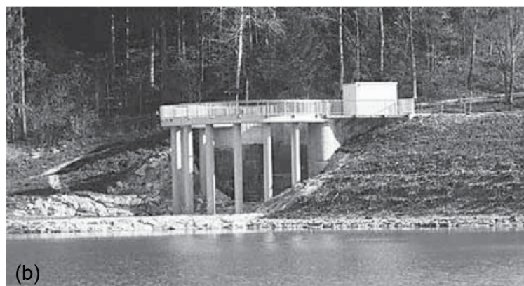
Figure 31: a) Ancien évacuateur de crue avec grand râtelier à BF à Grüntensee et b) nouveaux piliers de râtelier en amont (Photo: Hartlieb 2015).
