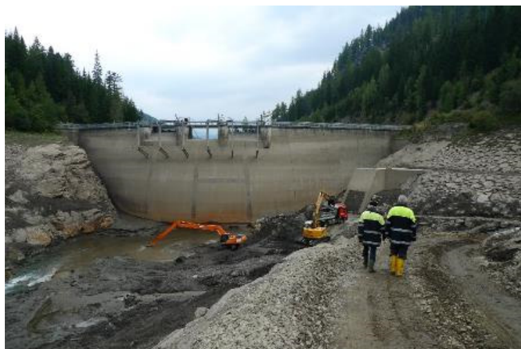
Figure 28: Grand râtelier à BF au barrage de Paalbach en Autriche (Photo: Ministère fédéral de l'Agriculture, des Forêts, de l'Environnement et de la Gestion des l'Eaux, Autriche).
