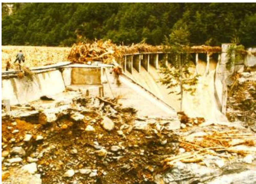
Figure 3: Obstruction de l'EDC du barrage en raison de la présence de bois flottant et érosion partielle du noyau après les crues de 1978 (Source: Ofima)
