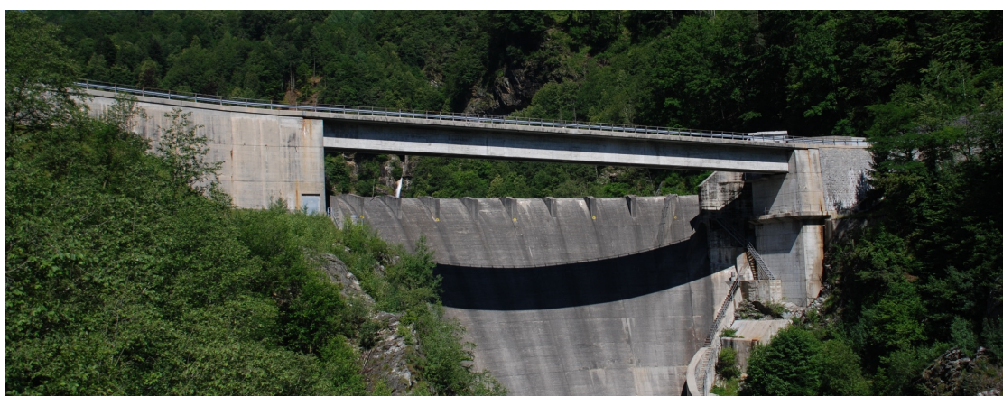
Figure 10: a) Blocage de la structure d'entrée de l'évacuateur de crue du barrage (évacuateur de crue avec pont de déversoir) au barrage de Palagnedra, canton du Tessin, 1978; (b) nouvelle structure d'entrée de l'évacuateur du barrage sans pont de déversoir (Photos: Ofima).
