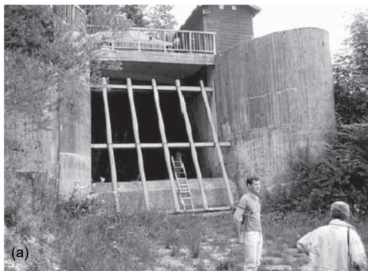
Figure 30: Grand râtelier à BF situé en amont du barrage de Rotlech en Autriche (Photo: Ministère Fédéral de l'Agriculture, des Forêts, de l'Environnement et de la Gestion des Eaux en Autriche).
