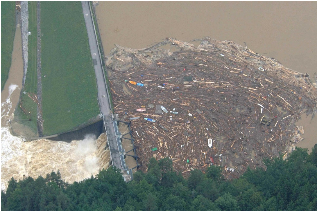
Figure 2: Débris flottants devant l'évacuateur du barrage de Thurnberg sur la rivière Kamp en Basse-Autriche lors de la crue extrême de 2002 (Photo: Office fédéral de l'agriculture et des forêts, de l'environnement et de la gestion de l'eau, Autriche).
