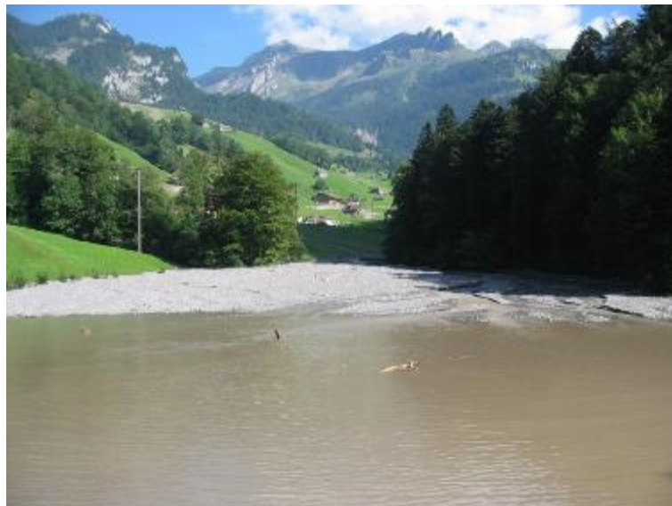
Figure 4: Dépôts de sédiments dans le réservoir de Käppelistutz après les crues de 2005 (Source: EW Nidwalden)
