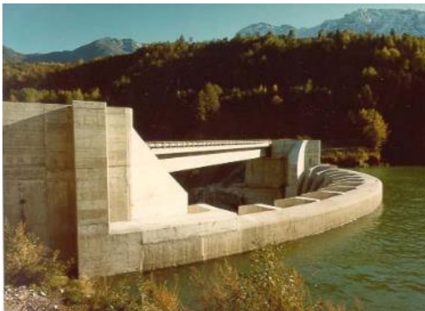
Figure 5: Nouvel EDC du barrage sans piliers et avec nouveau pont (Source: Ofima)
