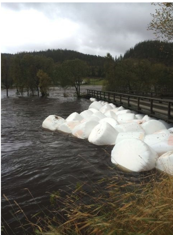
Figure 1: Evacuateur obstrué par des balles d'ensilage à Trondelag, Norvège (Photo: L. Lia, NTNU).
