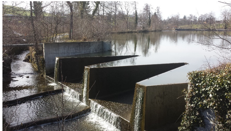
Figure 25: Structure d'entrée de l'évacuateur de crue en forme de déversoir en labyrinthe avec une grande crête à déversement et largeur de dégagement à Sternenweiher (canton de Zurich, Suisse) (Photo: Boes, 2015).
