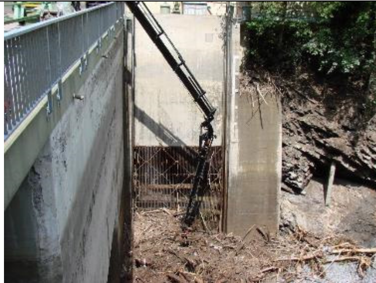
Figure 6: Enlèvement mécanique de bois flottant à la structure d'entrée après la crue de 2010 (Source: ebs Energie AG)
