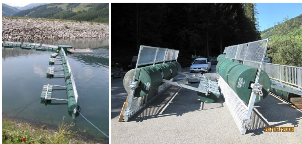
Figure 34: Râtelier flottant (Photo: H. Czerny, Ministère Fédéral de l'Agriculture, des Forêts, de l'Environnement et de la Gestion des Eaux, Autriche).
