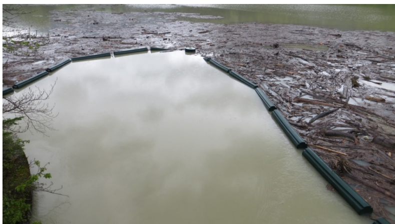
Figure 4: Situation avant la brèche de la barrière flottante de mai 2015
