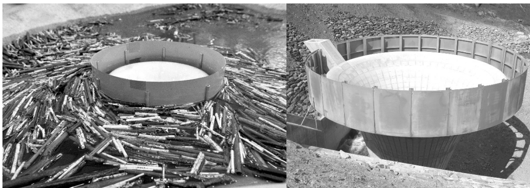
Figure 32: Entrée de l'évacuateur en tulipe avec paroi d'écumage à la Kelchbach à Naters, diamètre d'environ 14 m. A gauche: Expérience sur modèle; A droite: Prototypé (Photos: Lange & Bezzola 2005).
