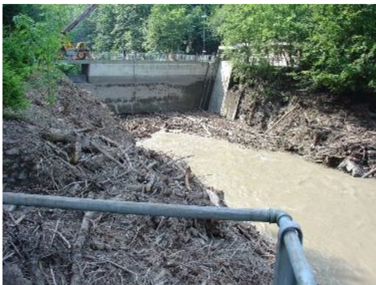
Figure 5: Obstruction de structure d'évacuation due au bois flottant après la crue de 2010 (Source: ebs Energie AG)
