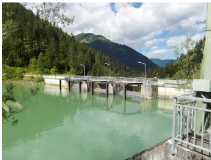
Figure 30: Grand râtelier à BF situé en amont du barrage de Rotlech en Autriche (Photo: Ministère Fédéral de l'Agriculture, des Forêts, de l'Environnement et de la Gestion des Eaux en Autriche).
