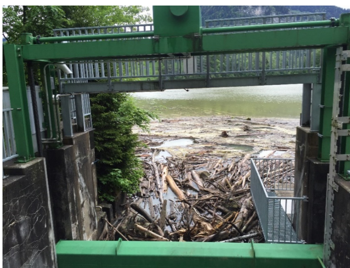
Figure 6: Situation actuelle en cas de crue; le grand risque d'obstruction reste inacceptable
