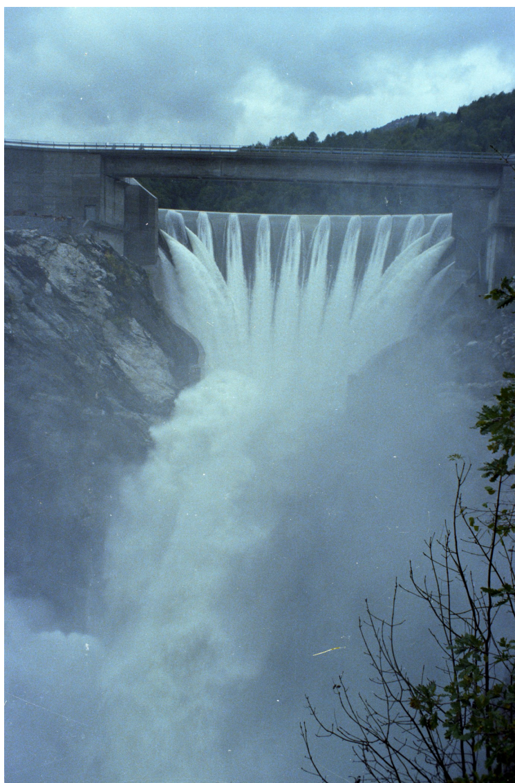
Figure 6: Nouvel EDC du barrage en fonction (Source: Ofima)
