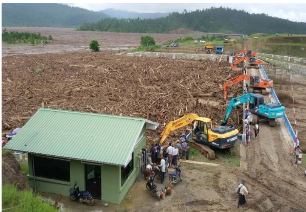
Figure 11: Enlèvement de débris flottants avec des excavatrices au barrage de Yarzagyo, lors de la crue de 2015 au Myanmar (Photo: M. Wieland).
