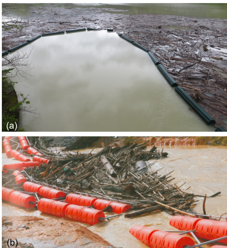
Figure 35: a) Barrière à BF rompue au barrage de Montsalvens (canton de Fribourg, Suisse) lors des crues de 2015 (annexe 2, photo: Groupe E); b) Centrale hydroélectrique de Tulu Ter, Malaisie: barrière flottante avec de gros volumes de BF à l'entrée du tunnel de contournement (photo: Worthington).
