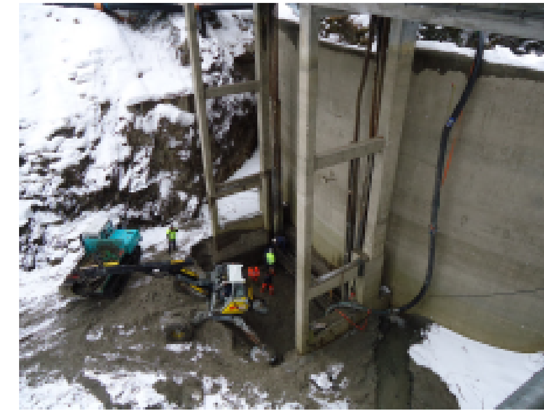
Fig. 9: Dégagement de la vanne
