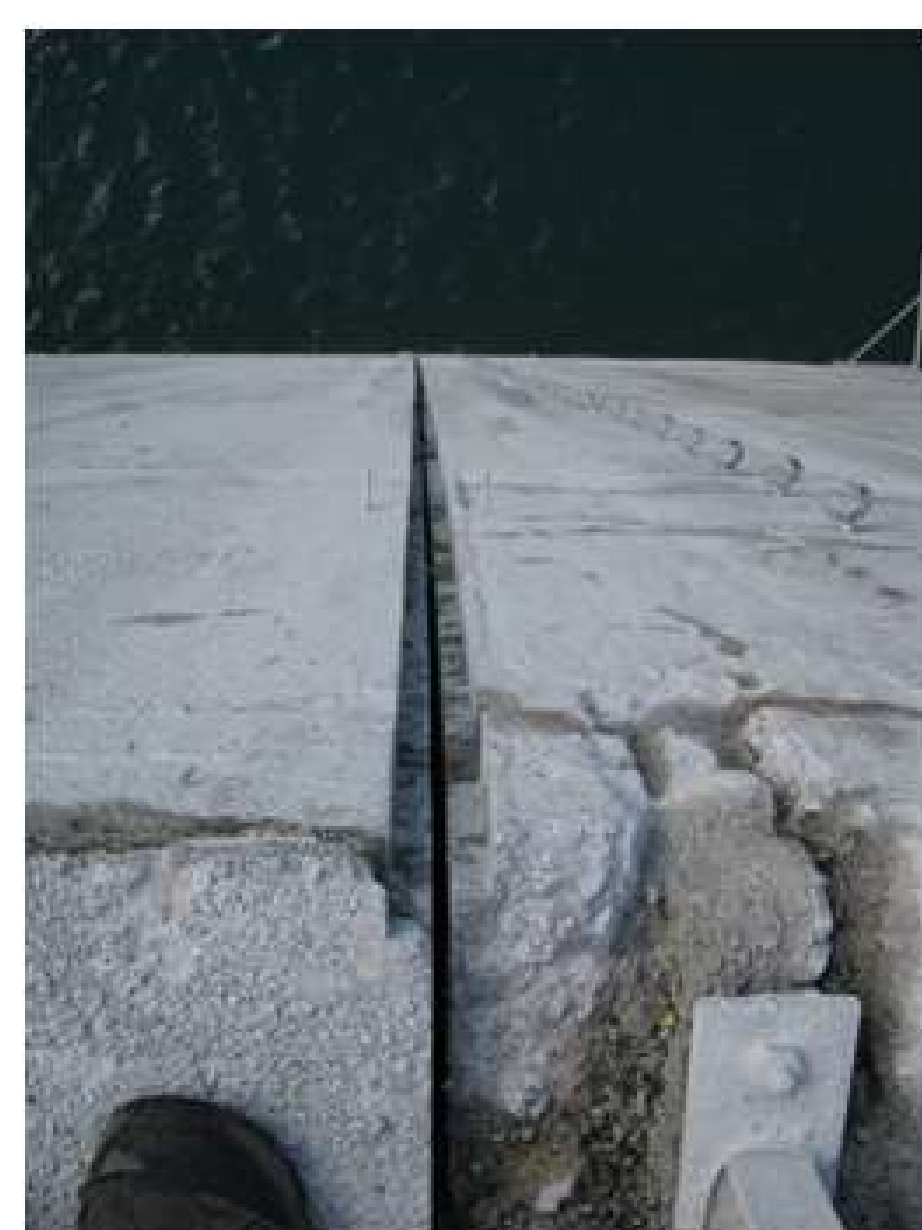
Fig. 2: pendule amont-aval – fissure – planimétrie du couronnement
