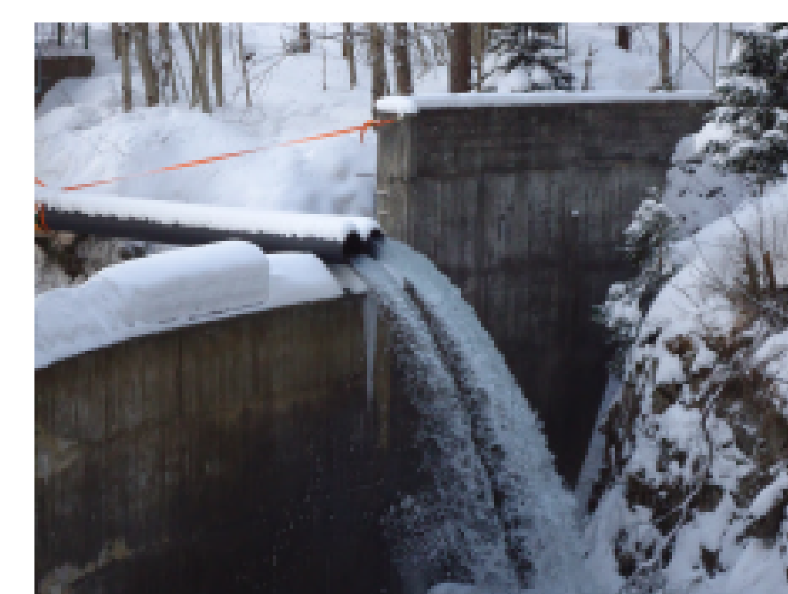
Fig. 8: Vidange de la retenue par pompage
