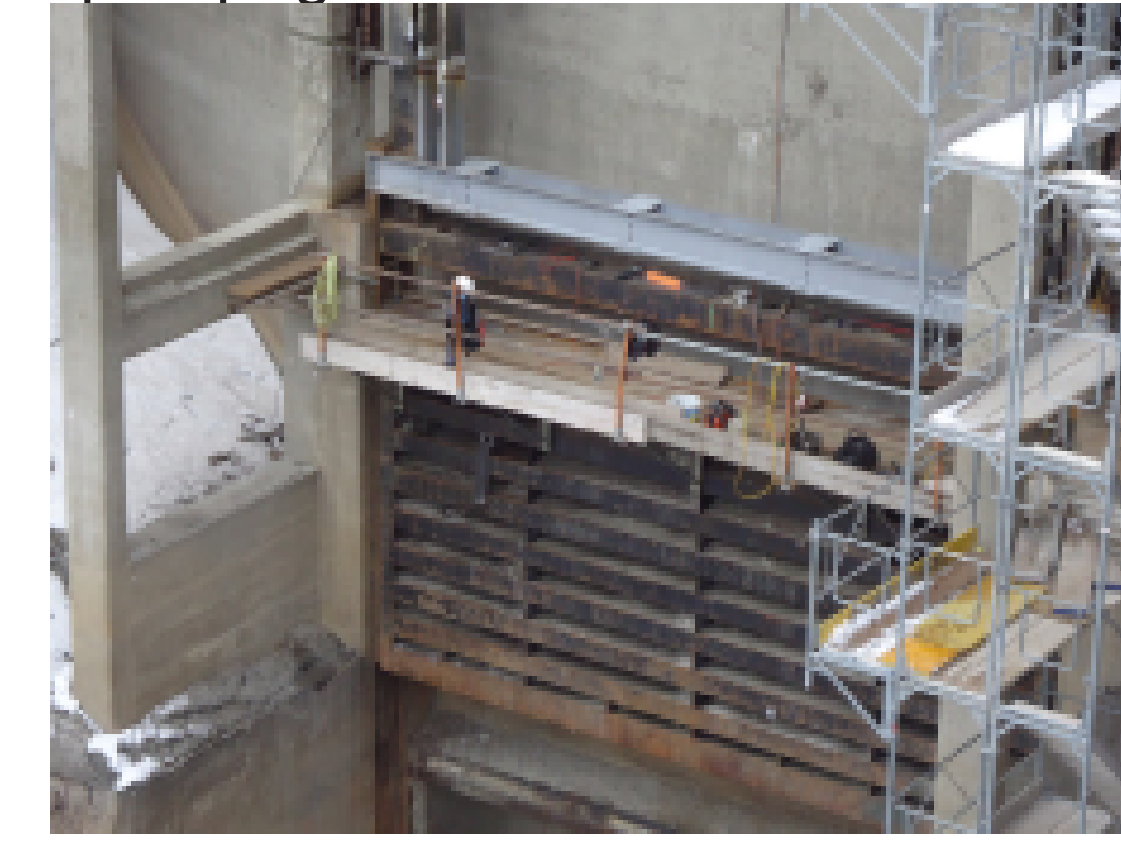
Fig. 10: Assainissement de la vanne de décharge
