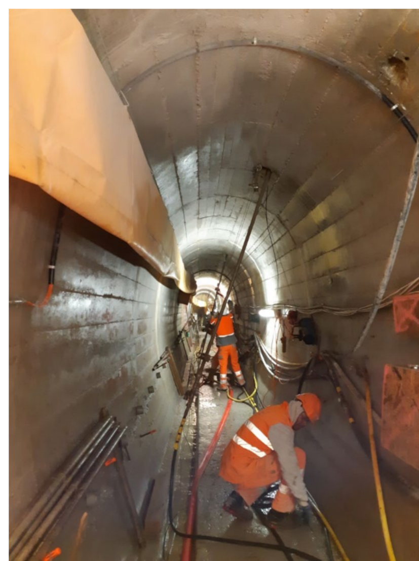
Fig. 2: Injections en rive droite.
