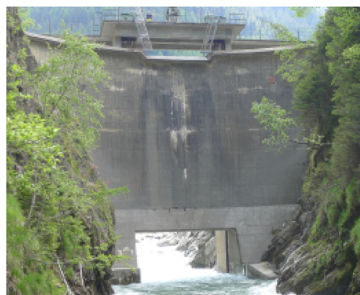
Fig. 1: Parement aval. Vidange ouverte
