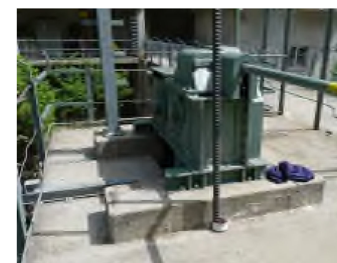
Fig. 11: Entraînement d'origine de la vidange (chaînes) et système redondant (barres DYWIDAG)
