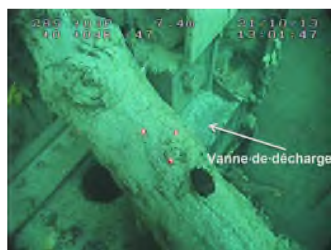
Fig. 3: Image du ROV. Vanne de décharge cassée, bloquée par une souche
