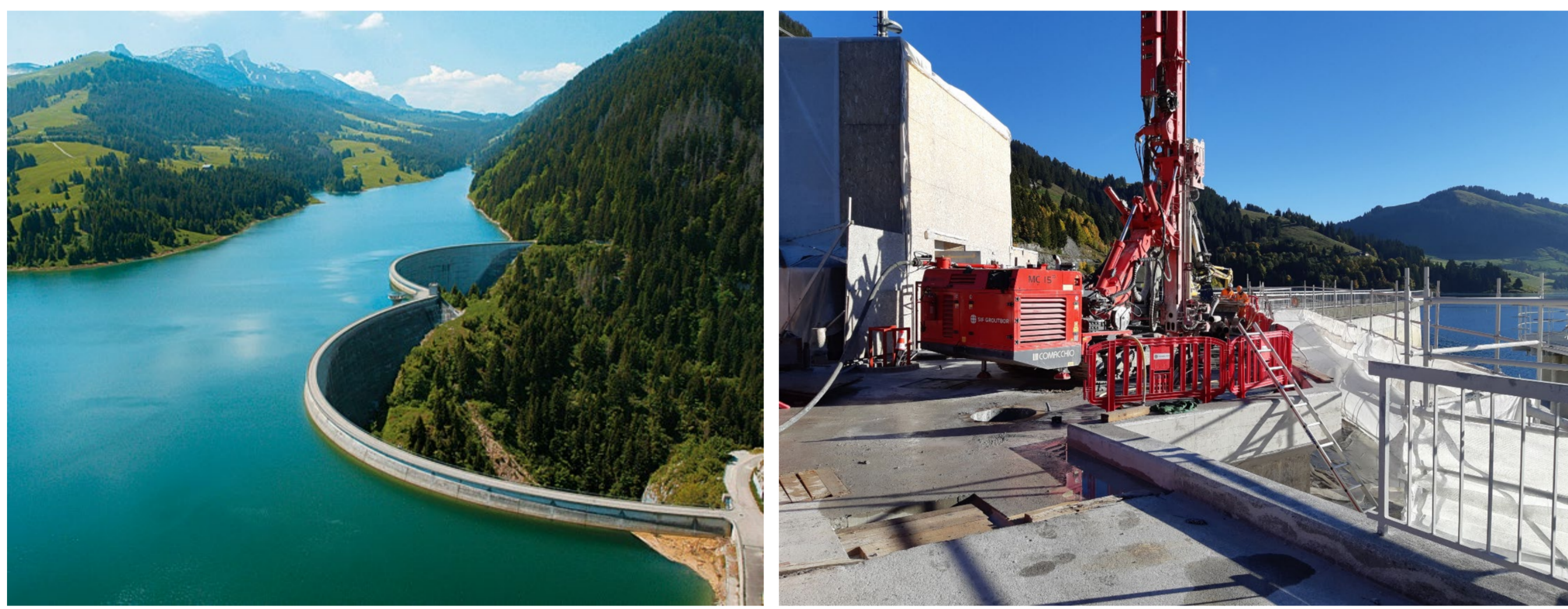
Fig. 1: Barrages de l'Hongrin. Fig. 2: Forage pour les ancrages précontraints.
