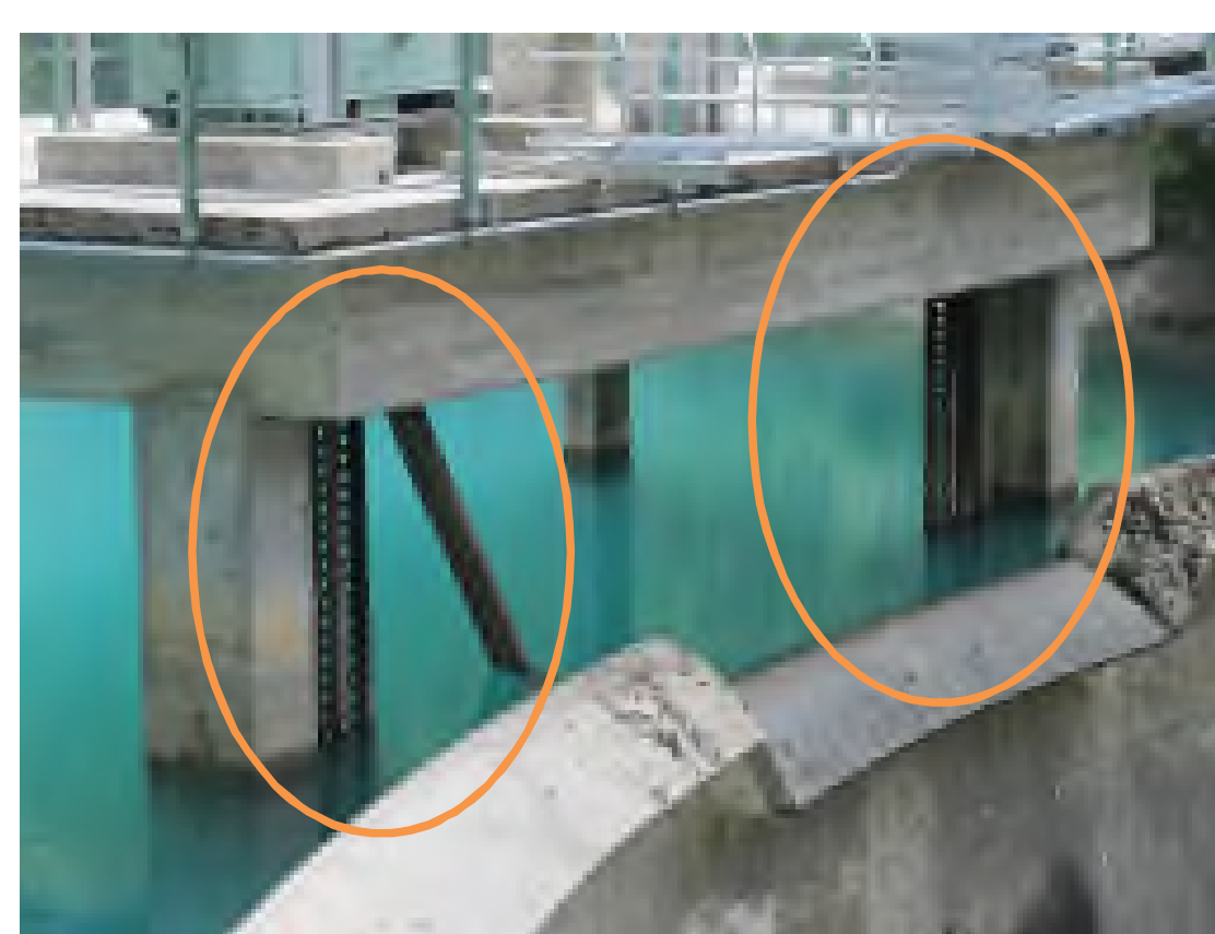
Fig. 4: Entraînement de la vanne avec chaînes
