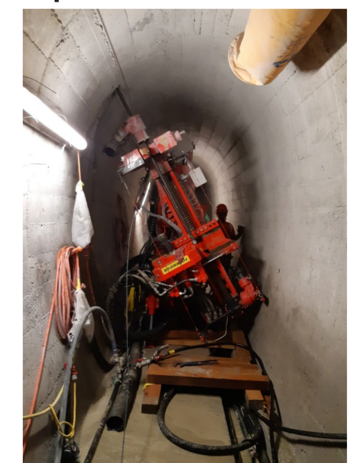
Fig. 6: Exécution des forages d'injection.
