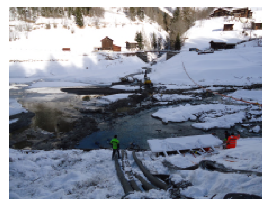
Fig. 7: Construction de la digue
