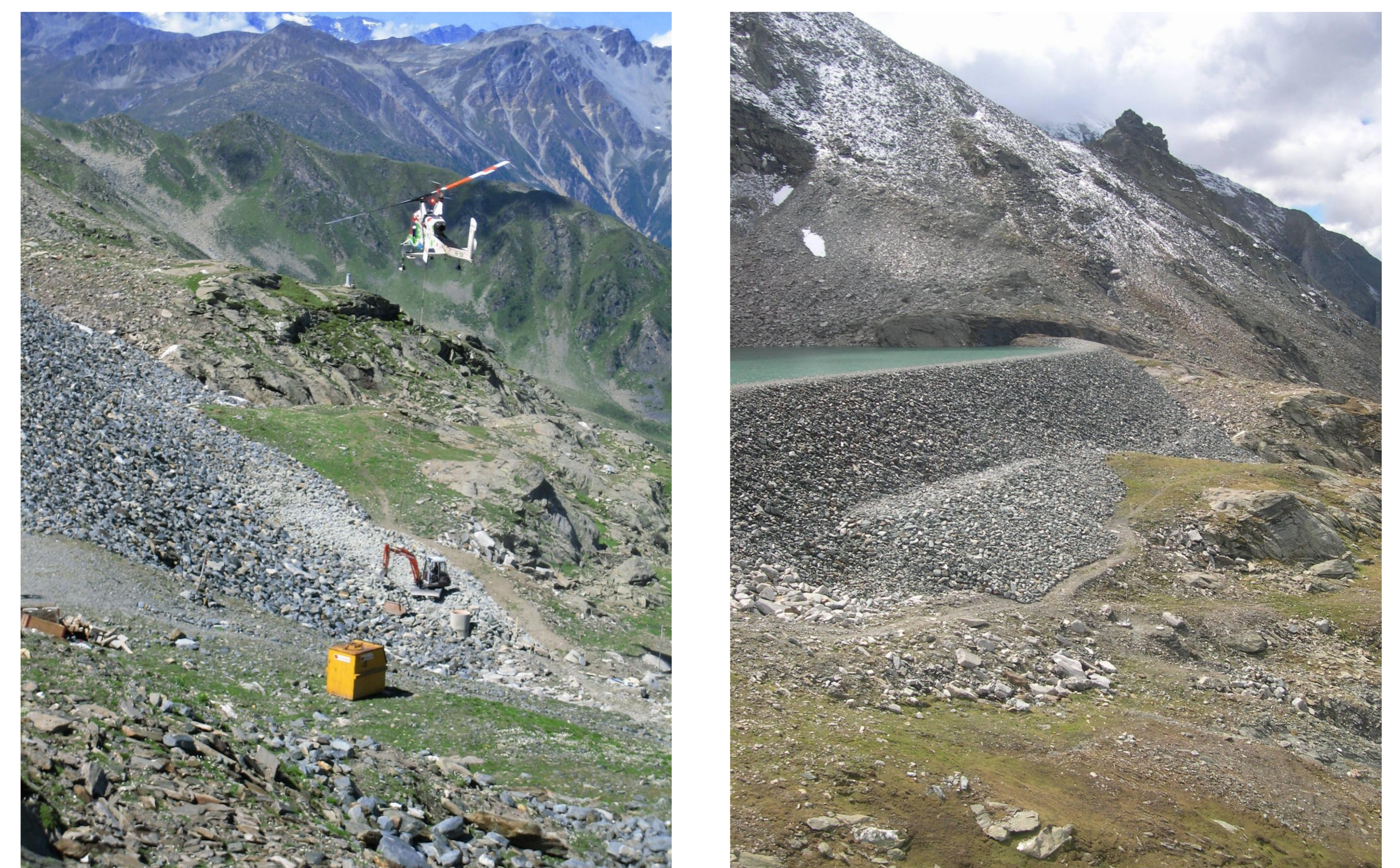
Abb. 4: Fotos während der Bauarbeiten.
