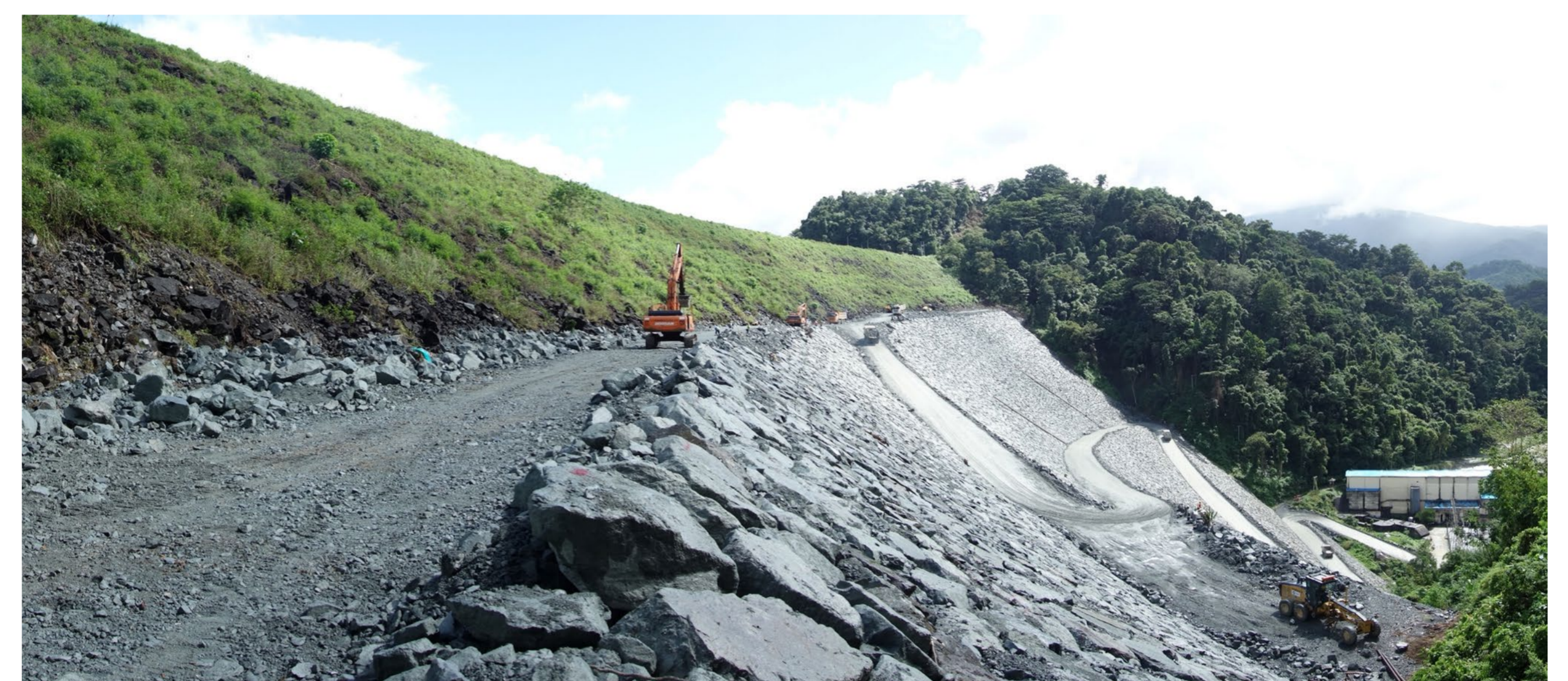
Abb. 3: Anschüttung der luftseitigen Böschung des Hauptdamms in Ausführung
