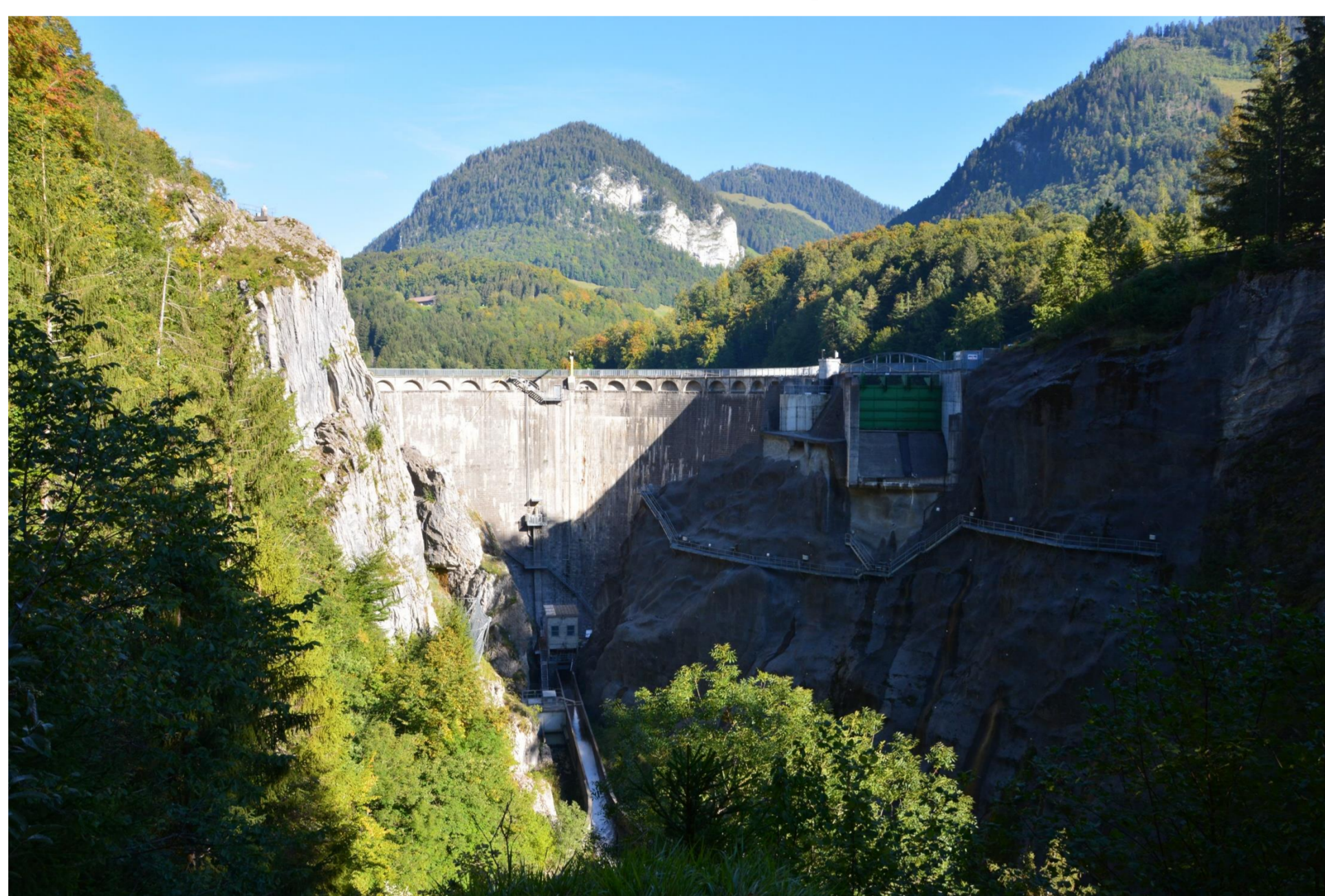
Fig. 1: Vue aval du barrage
