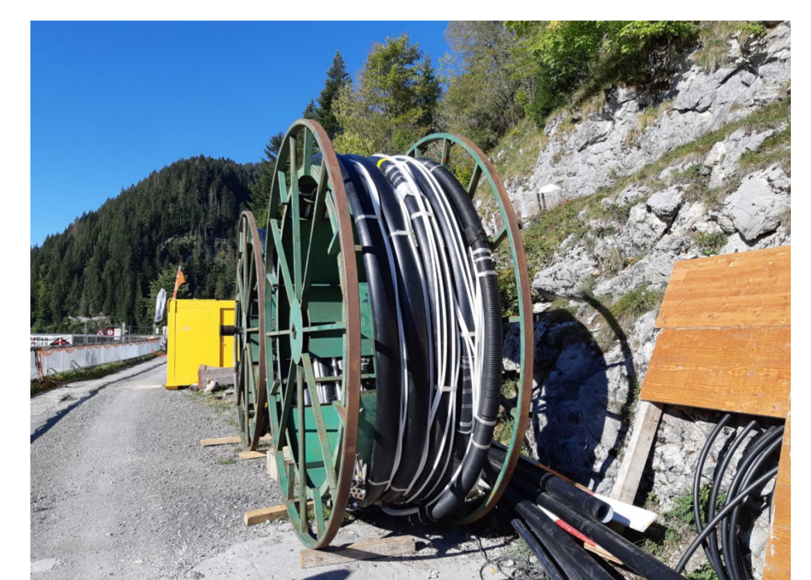
Fig. 9: Ancrage sur bobine
