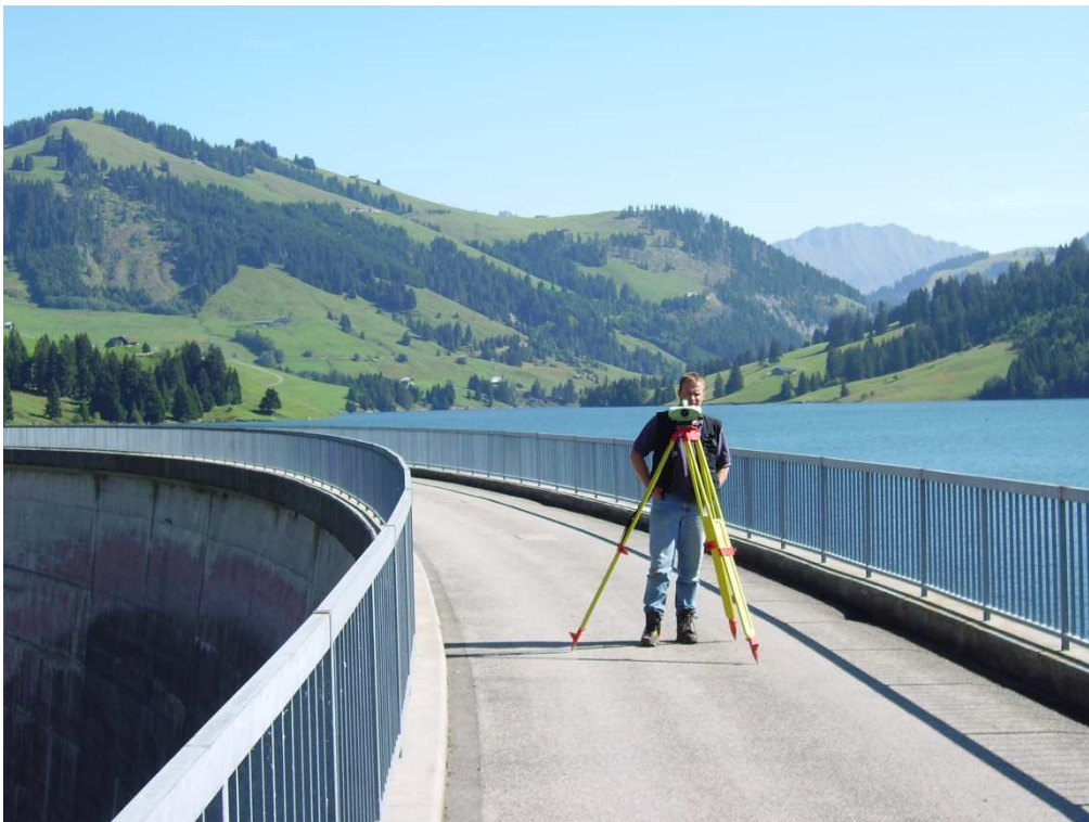
Abbildung 14: Präzisionsnivellement über die Mauerkrone
