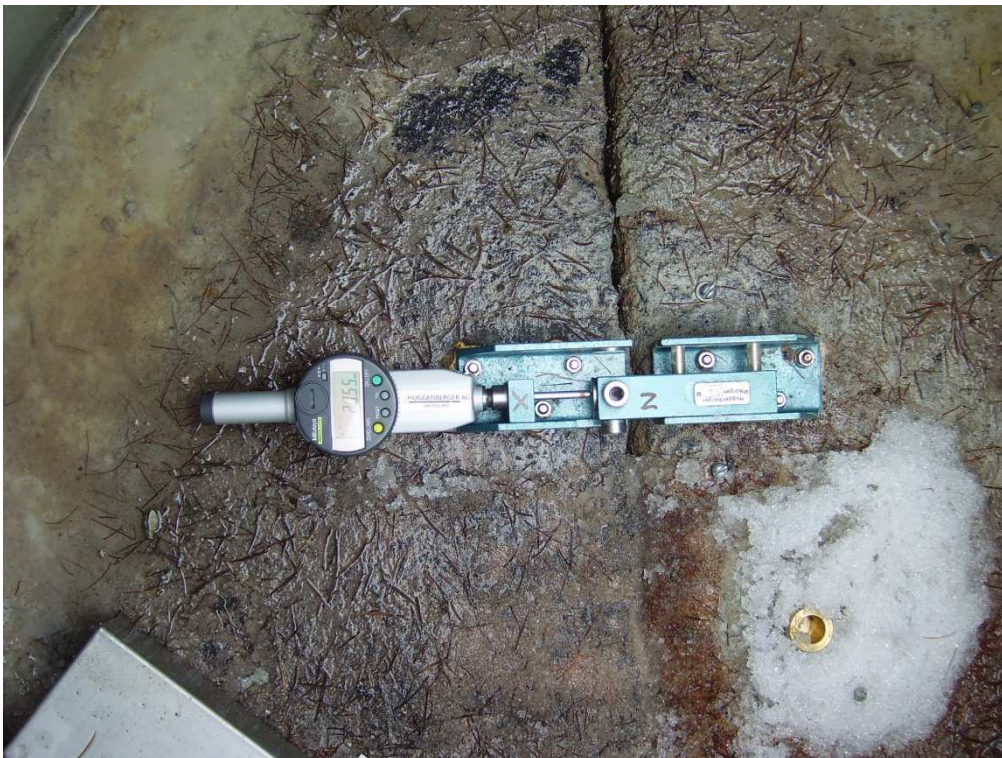
Abbildung 16: Jointmeter-Messungen in Kombination mit geodätischer Messung
