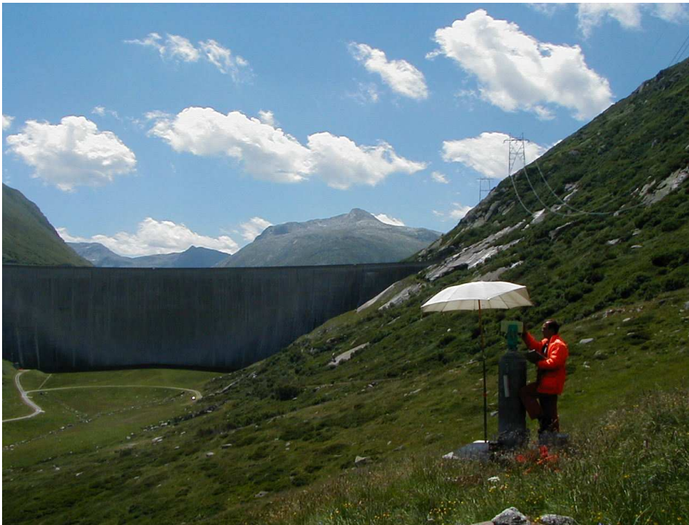
Abbildung 5: Messpfiler vom erweiterten Netz der Staumauer Sta. Maria
