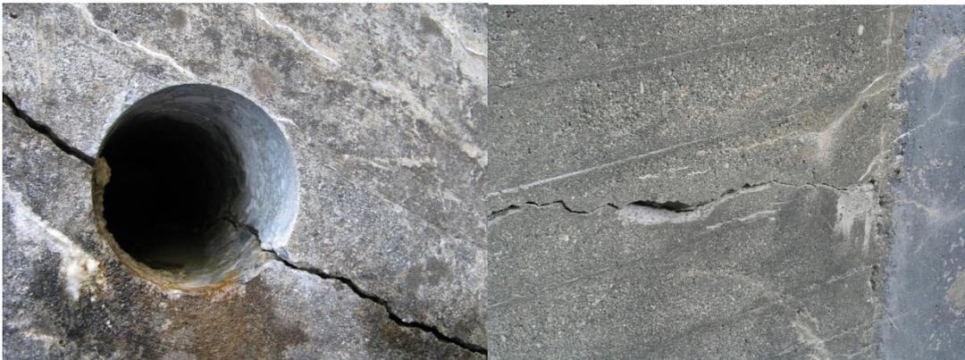
**Abbildung 18:** Bestimmung der Tiefe eines strukturellen Risses auf der Luftseite einer AAR betroffenen Bogenmauer mit Hilfe einer Bohrkernentnahme (links) und Riss mit Versatz auf der Wasserseite einer Bogenmauer.
