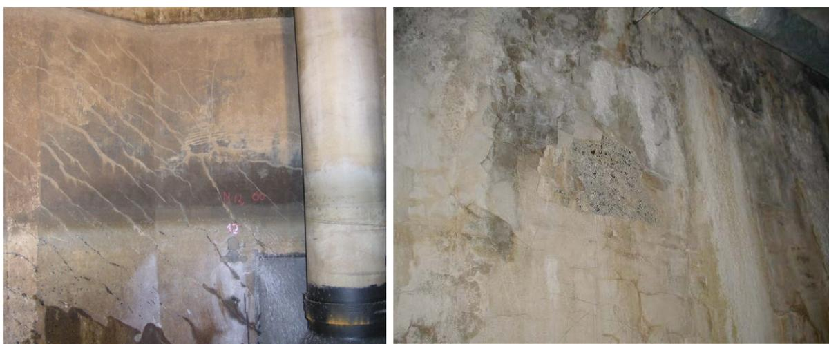
**Abbildung 61:** Zustand der Oberfläche von einigen ständig eingestauten Teilen der Zentrale.
