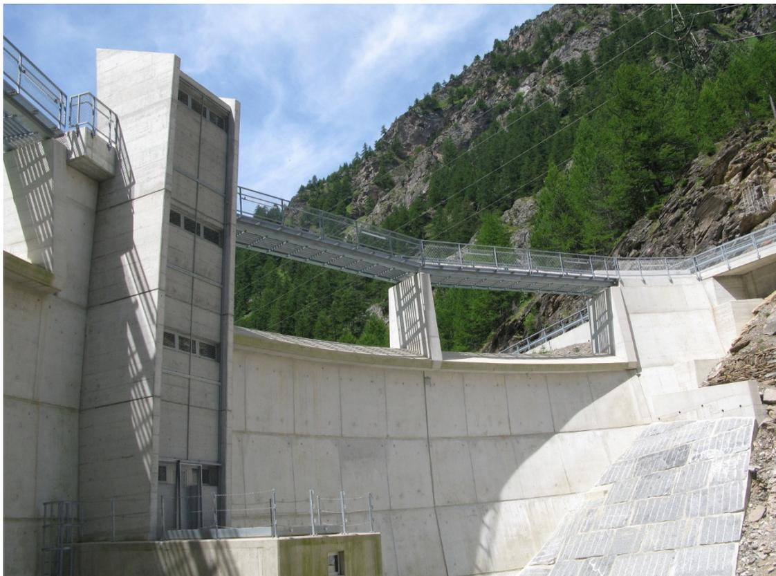
**Abbildung 22:** Mit zugeführtem, nicht reaktivem Zuschlag neu erstellte Staumauer Sera im Zwischbergental bei Gondo (VS) [17].
