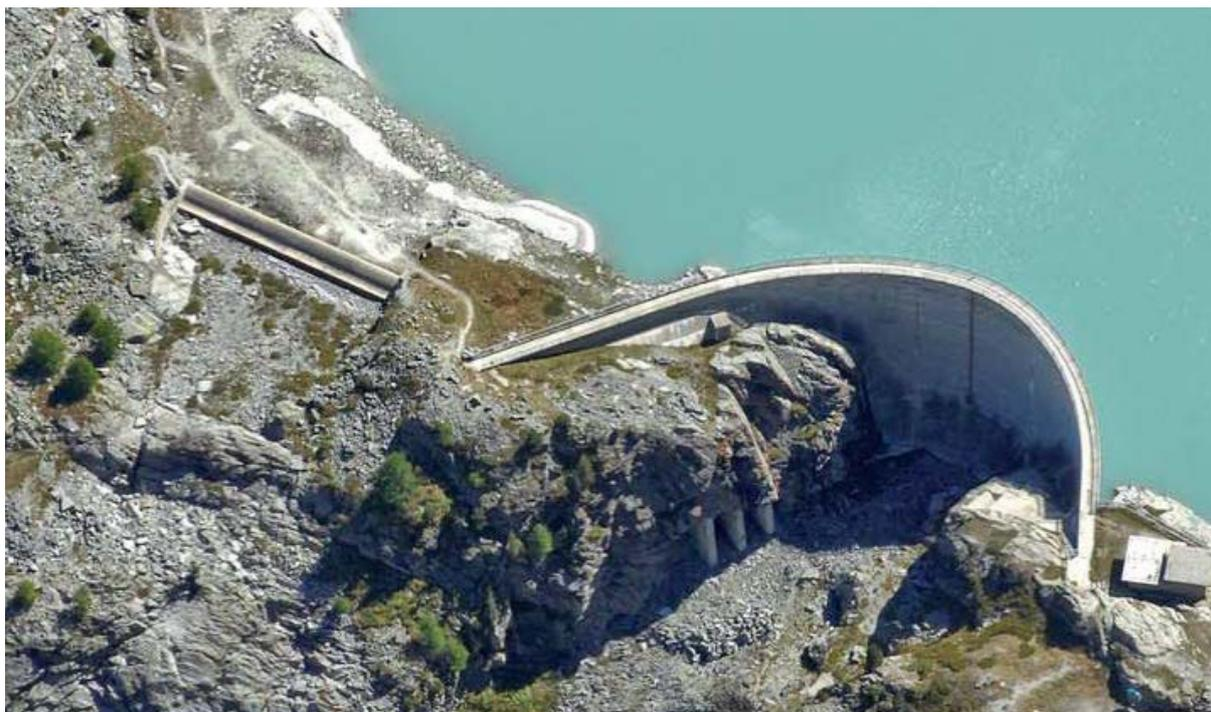
**Abbildung 58:** Luftbild der Stauanlage Turtmann mit der Hochwasserentlastung auf der rechten Flanke.
