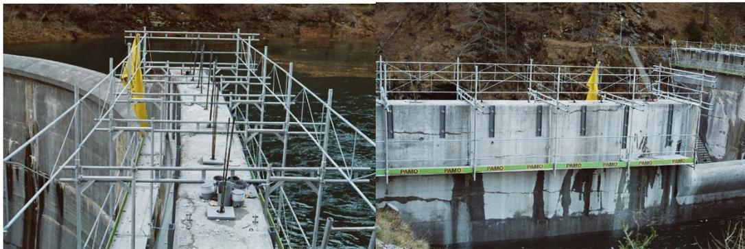
**Abbildung 19:** Provisorische Sicherung einer AAR-geschädigten Staumauerkrone mit vertikalen Vorspannankern und seitlichen Stahllaschen für den Hochwasser- und Erdbebenfall.
