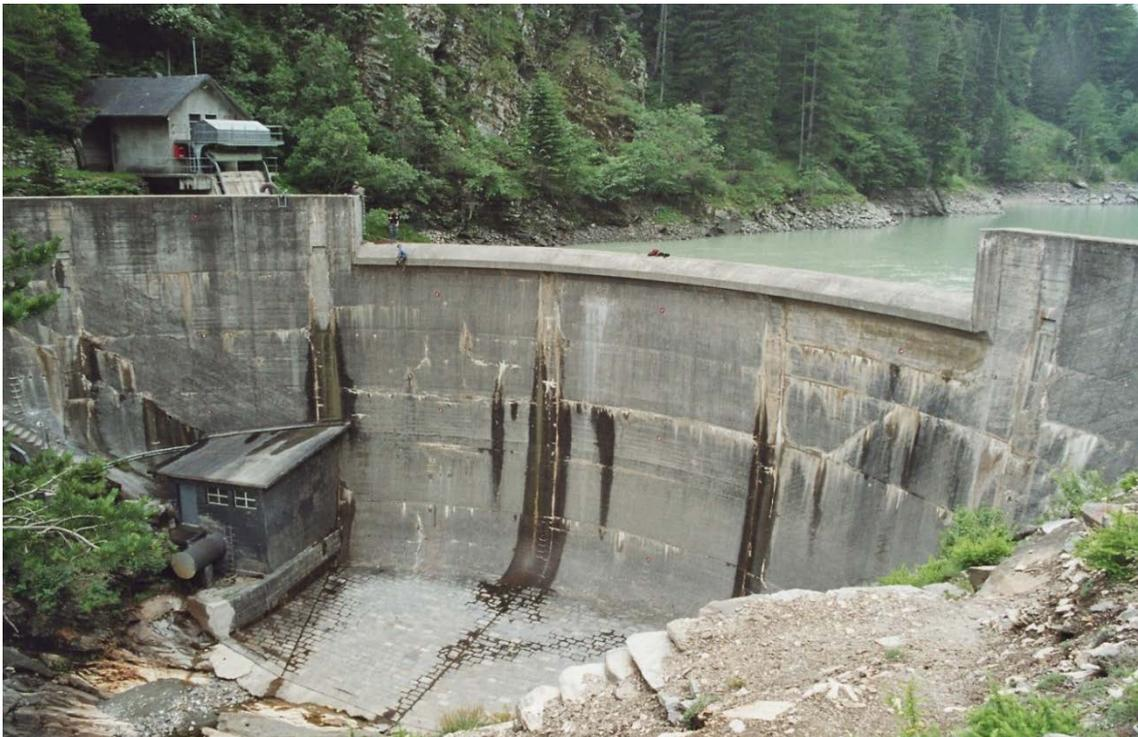
**Abbildung 1:** Alte, durch AAR geschädigte Staumauer Sera im Zwischbergental bei Gondo (VS).
