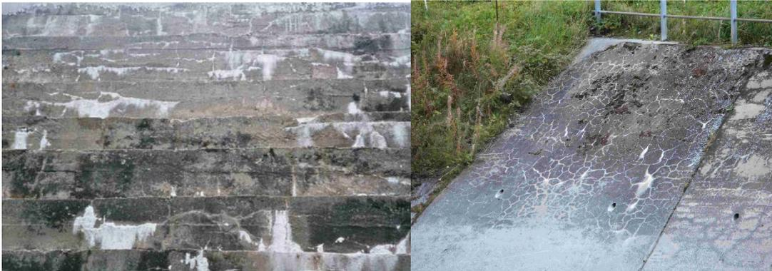
**Abbildung 13:** AAR-Risse mit starken Ausblühungen auf der Luftseite einer Abgetreppete Gewichtsstaumauer (links) und Uferschutz im Unterwasserbereich eines Wehres mit netzförmigen AAR-Rissen (rechts).
