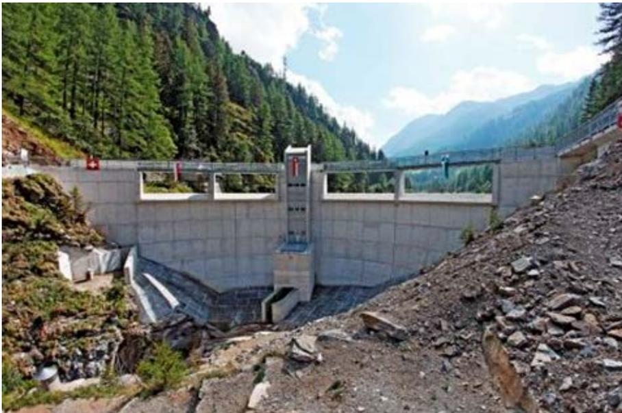
**Abbildung 73:** Abbruch der alten Staumauer und luftseitige Ansicht der neuen Mauer.
