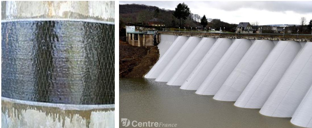
**Abbildung 83:** Beispiele von Minderungsmassnahmen: a) Kohlefaser-Schutzschicht; b) Schutz mit einer PE-Membrane.
