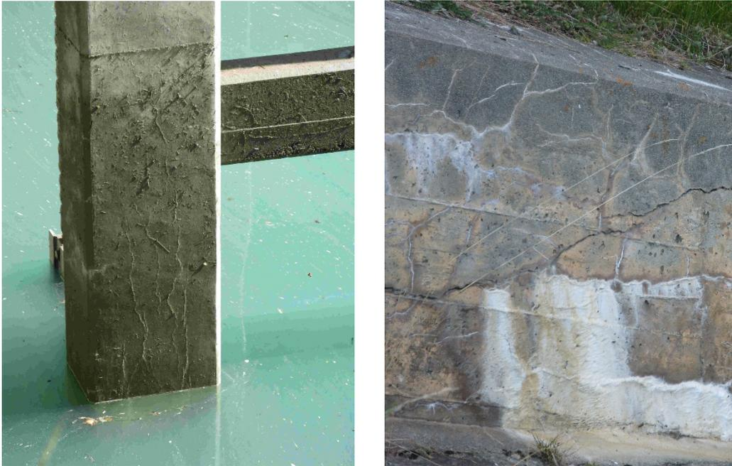
**Abbildung 16:** Stütze eines Bedienungssteiges mit AAR-Rissen in Richtung der vertikalen Hauptbeanspruchung (links) und Stützmauer einer Hochwasserentlastung mit klaffendem Riss (rechts).
