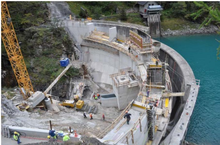
**Abbildung 72:** Bau der neuen Staumauer Sera unmittelbar luftseits der alten Mauer.
