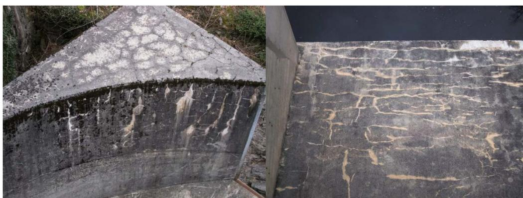
**Abbildung 12:** Netzförmige AAR-Risse beim Auslauf einer Hochwasserentlastung (links) und Risse am Einlauf einer Hochwasserentlastung mit bevorzugter Rissrichtung aufgrund der vorhandenen Kräfte (rechts).
