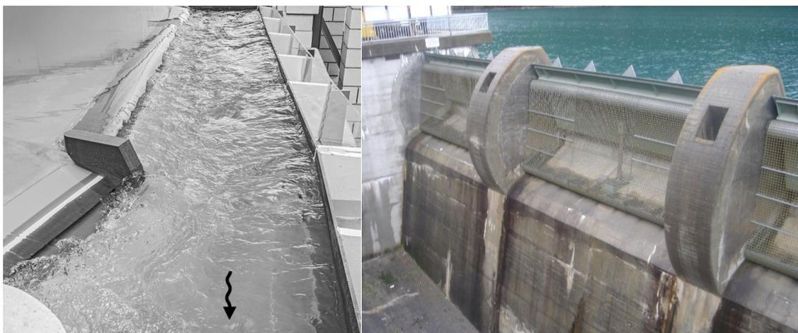
**Abbildung 24:** HWE-Einlaufbauwerk in eine Sammelrinne mit Klappen. Links: Draufsicht auf ein Modell der HWE des Trängslet-Damms in Schweden mit einfeldriger Klappe am unterstromigen Wehre (Lucas et al. 2015); rechts: mehrfeldriges Wehr mit Klappen und Strahlaufreisser an der Staumauer Punt dal Gall (Foto: Boes, 2009).
