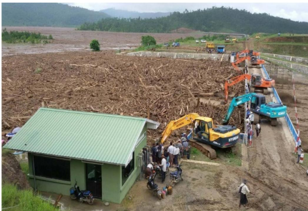
**Abbildung 11:** Treibgutentnahme durch Bagger an der Stauanlage Yarzagyo, Myanmar, während dem Hochwasser 2015 (Foto: M. Wieland).
