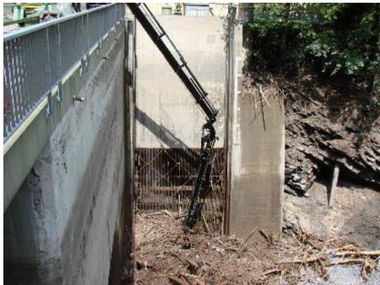
Abbildung 6: Maschinelle Entnahme des Schwemmholzes nach dem Hochwasserereignis 2010 im Bereich der Wasserfassung (Quelle: ebs Energie AG)
