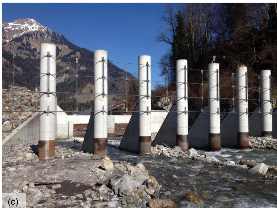
**Abbildung 9:** Schwemmholzurückhalt mittels (a) Stahlrechen im Geschiebesammler am Dorfbach Sachseln, Kanton Obwalden (Foto: VAW), (b) Netzsperrre am Faulengraben, Oberbayern, Deutschland (Foto: Versuchsanstalt für Wasserbau und Wasserwirtschaft, TU München) sowie (c) Kombination Schwemmholz-/Seilrechen an der Chiene in Kien, Kanton Bern (Foto: Emch + Berger AG).
