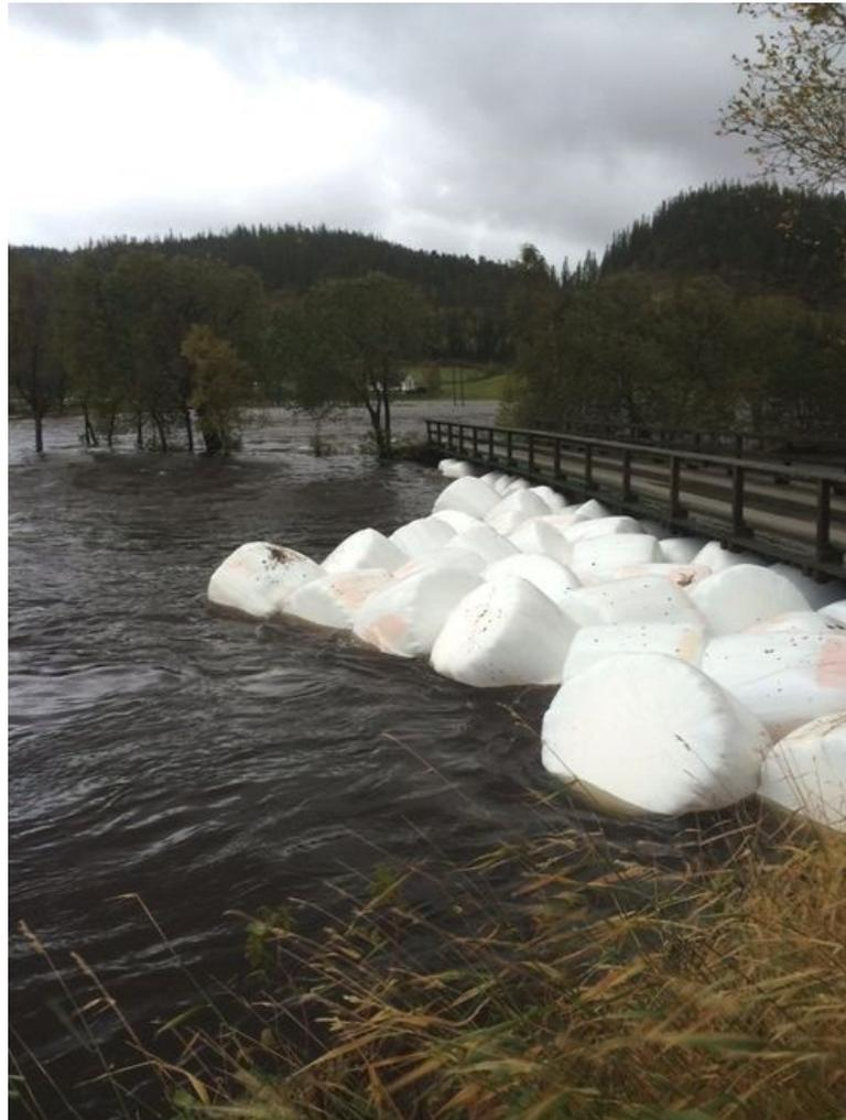
**Abbildung 1:** Durch Siloballen verkleaste Hochwasserentlastung in Trondelag, Norwegen (Foto: L. Lia, NTNU).
