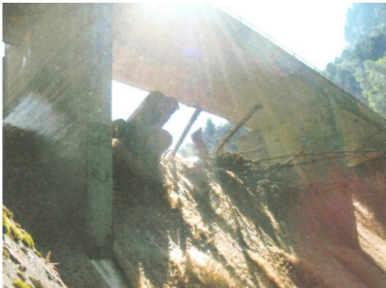
Abbildung 3: Schwemmholzverklausung an der HWE wahrend des Hochwassers 2005 (Quelle: EW Nidwalden)
