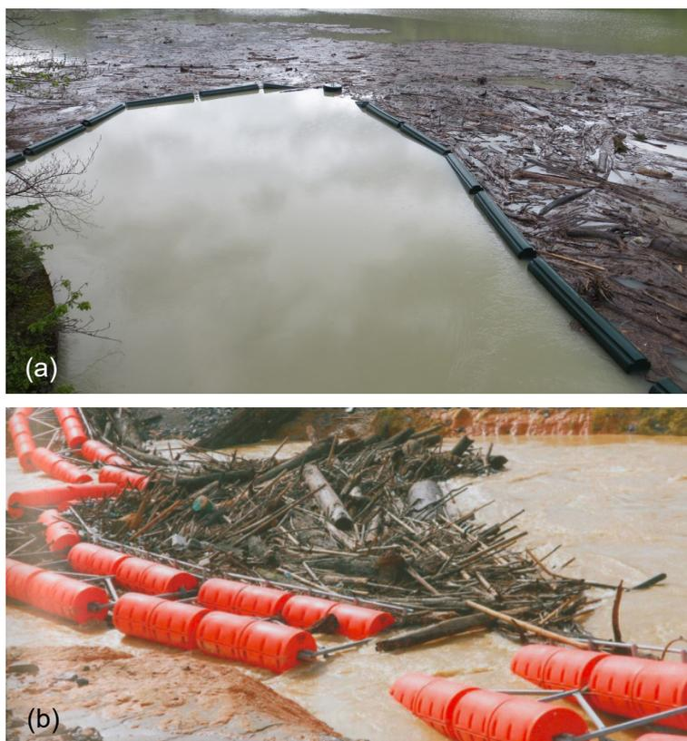
**Abbildung 35:** a) Schwemmholzsperrre an der Talsperre Montsalvens (Kanton Fribourg), die beim Hochwasserereignis 2015 gebrochen ist (Anhang 2, Foto: Groupe e); b) Wasserkraftanlage Tulu Ter., Malaysia: Schwimmkette bei massivem Schwemmholzanzahl am Einlauf des Umleitstollens (Foto: Worthington).
