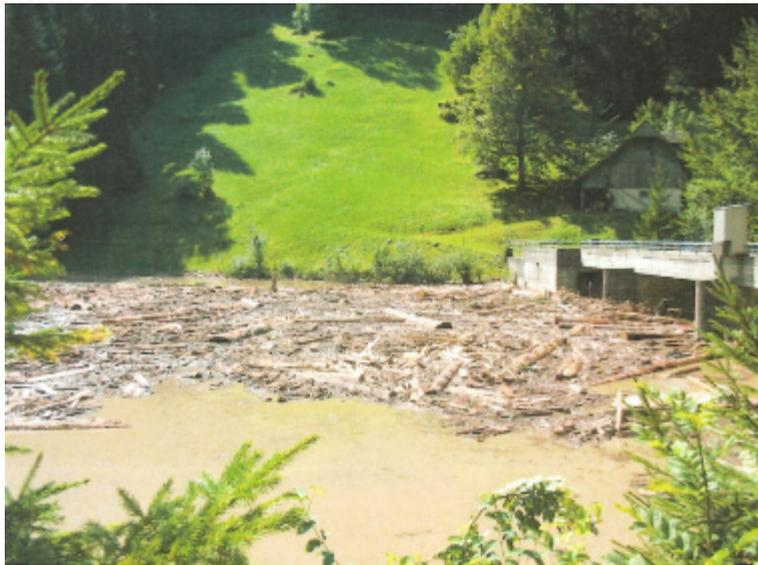
Abbildung 2: Schwemmholzverklausung an der HWE wahrend des Hochwassers 2005 (Quelle: EW Nidwalden)
