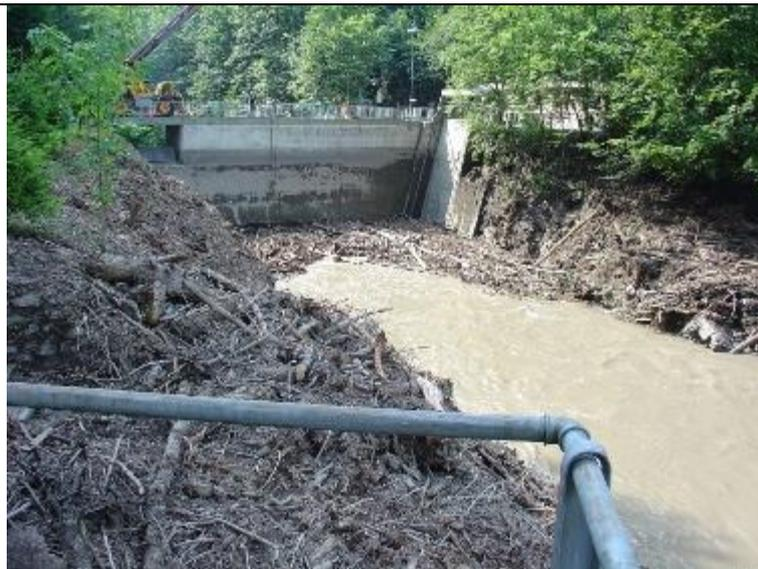
Abbildung 5: Schwemmholzverklausung beim Durchlass nach dem Hochwasser 2010 (Quelle: ebs Energie AG)
