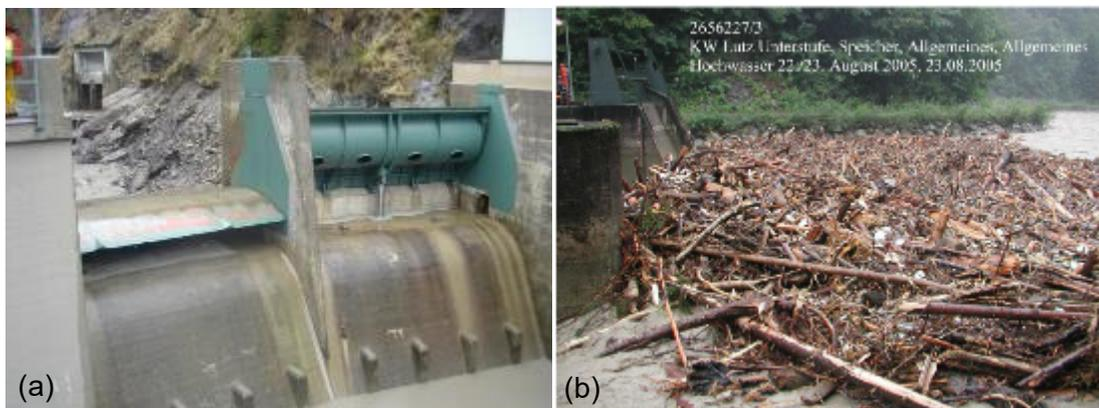
**Abbildung 41:** Speicher Gstins: (a) HWE mittels zwei Stauklappen (Foto: VAW) und (b) Verklausung während des Hochwassers 2005 (Fotos: Vorarlberger Illwerke AG).
