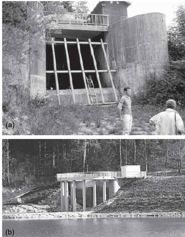
**Abbildung 31:** (a) Alter Schwemmholzrechen der HWE Grüntensee sowie (b) neue vorgelagerte Rechensäulen (Foto: Hartlieb 2015).
