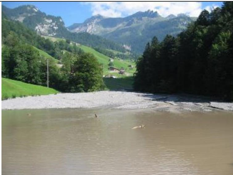
Abbildung 4: Geschiebeablagerungen im Staubecken Käppelistutz nach dem Hochwasser 2005 (Quelle: EW Nidwalden)
