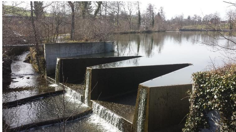
**Abbildung 25:** HWE-Einlaufbauwerk in Form eines Labyrinthwehres mit grosser Abwicklungslänge und lichter Weite am Sternenweiher (Kanton Zürich) (Foto: Boes, 2015).
