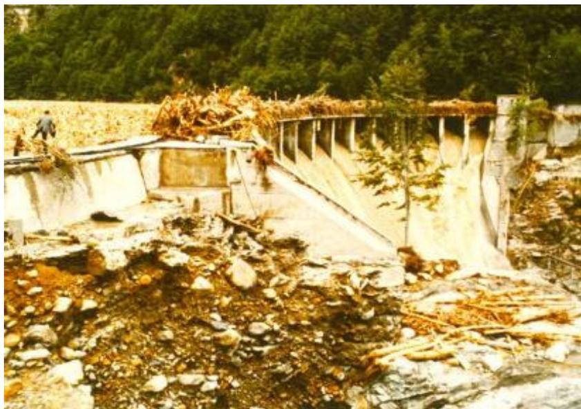
Abbildung 3: Schwemmholzverklausung an der HWE und teilerodierte Kernmauer nach dem Hochwasser 1978 (Quelle: Ofima)
