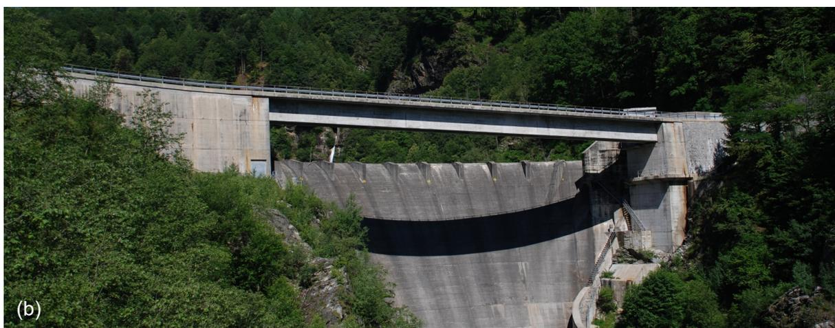
**Abbildung 10:** (a) Verklausung des HWE-Einlaufbauwerks (freier Überfall mit Wehrbrücke) an der Stauanlage Palagnedra, Kanton Tessin, 1978 (b) neues HWE-Einlaufbauwerk ohne Wehrbrücke (Fotos: Ofima).
