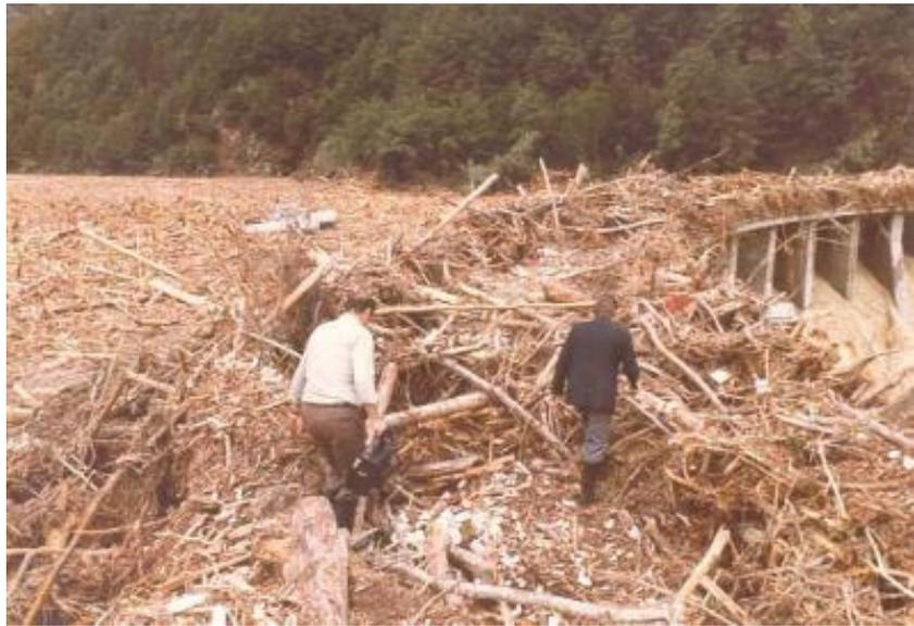
Abbildung 2: Schwemmholzverklausung an der HWE nach dem Hochwasser 1978 (Quelle: Ofima)
