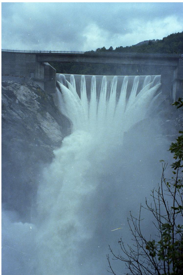
Abbildung 6: Neue HWE im Betrieb (Quelle: Ofima)
