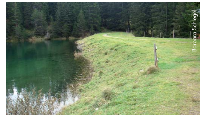
Süddamm (Erddamm mit Betonkern)
