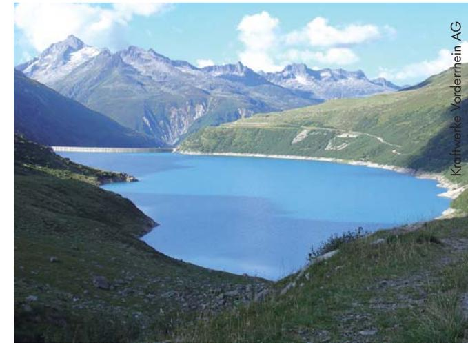
Die Kraftwerke Vorderrhein nutzen die Wasserkräfte des Vorderrheins und seiner Zuflüsse bis Tavanasa mit einem Einzugsgebiet von 315.8 km<sup>2</sup>. Der Stausee Nalps kommuniziert mit den beiden Stauseen Sta. Maria und Curnera, wobei die Stauziele von Sta. Maria und Nalps auf gleicher Höhe liegen, während dasjenige von Curnera 48 m höher ist.
